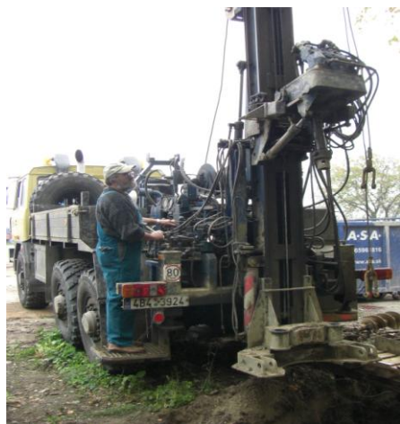
Realizácia hydrogeologického vrtu
