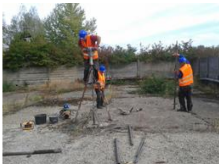
Vrtanie nevystrojeného vrtu – súprava Eijkelkamp
