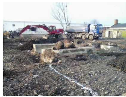
Dohľad pri odťažbe kontaminovanej zeminy
